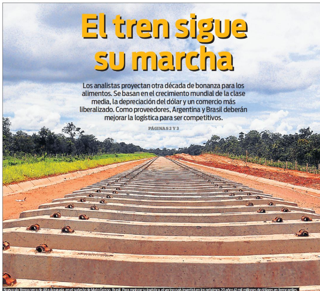
Nueva vía férrea cerca de Alta Araguaia, en el sudeste de Mato Grosso, Brasil. Para mejorar su logística, el vecino país invertirá en los próximos 20 años 41 mil millones de dólares en ferrocarriles.
